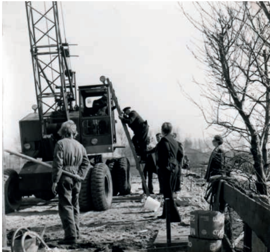
J. Hoogervorst slaat de eerste paal voor de kantine, februari 1975.
